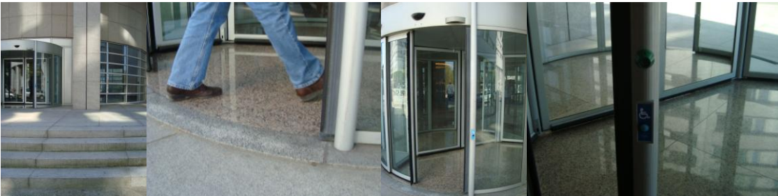
Figura 14 – entrada da torre da C.M. Maia, edifício mais recente; Figura 15 – soleira da entrada, C; Figura 16 – Porta automática rotativa PMC; Figura 17 – Pormenor do dispositivo limitador de velocidade para PMC.
