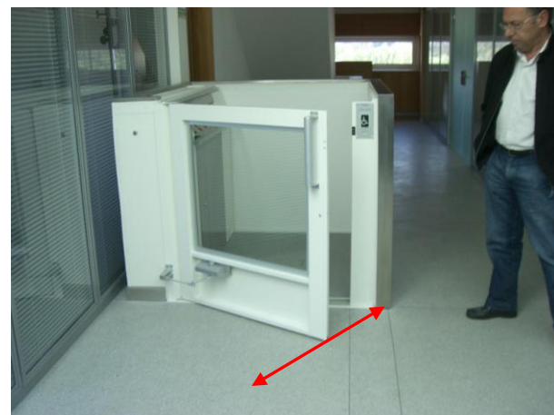
Figura 88 : plataforma elevatória no piso superior
