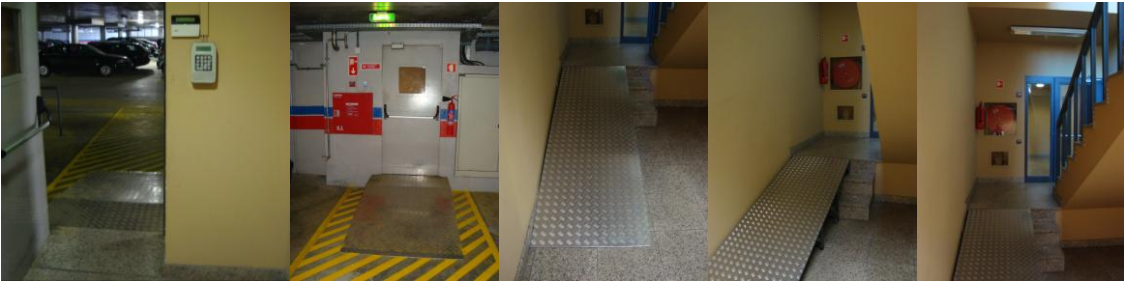
Figura 18 – área de estacionamento, cave da torre da C.M. Maia; Figura 19 – rampa de acesso à área das escadas, 20% inclinação; Figura 20e 21 – rampa de acesso ao nível do elevador, 25% de inclinação.
