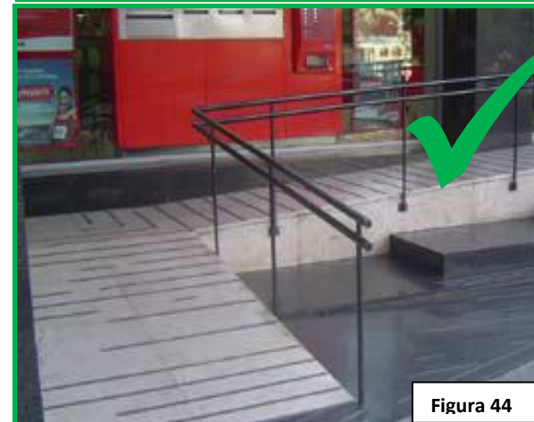
Rampa bem dimensionada e com corrimãos
