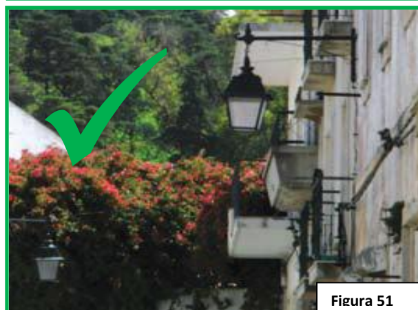
Candeeiros nas fachadas a 2.40m de altura
