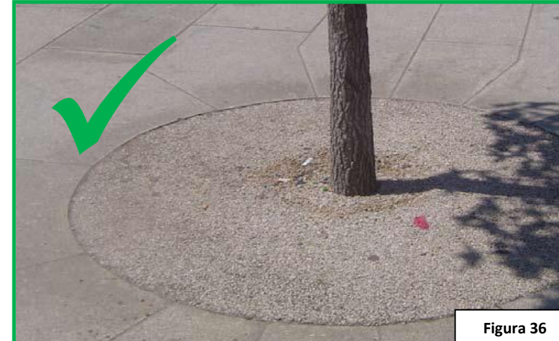
Resina compactada devidamente colocada
