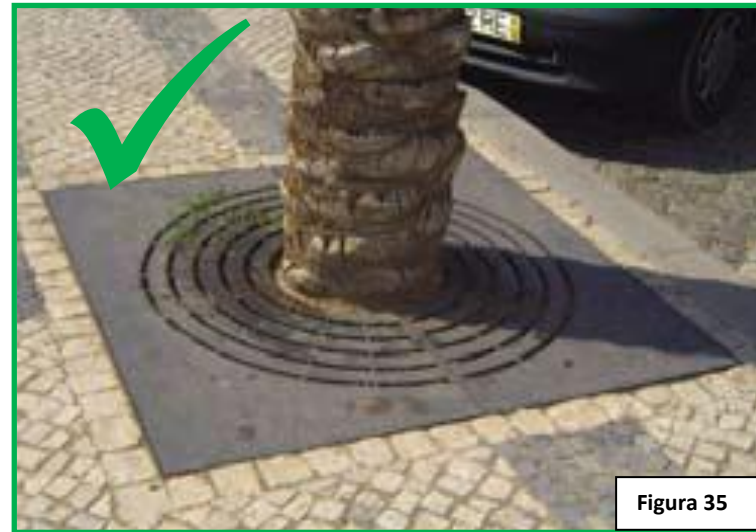
Grelha de protecção com design correcto
