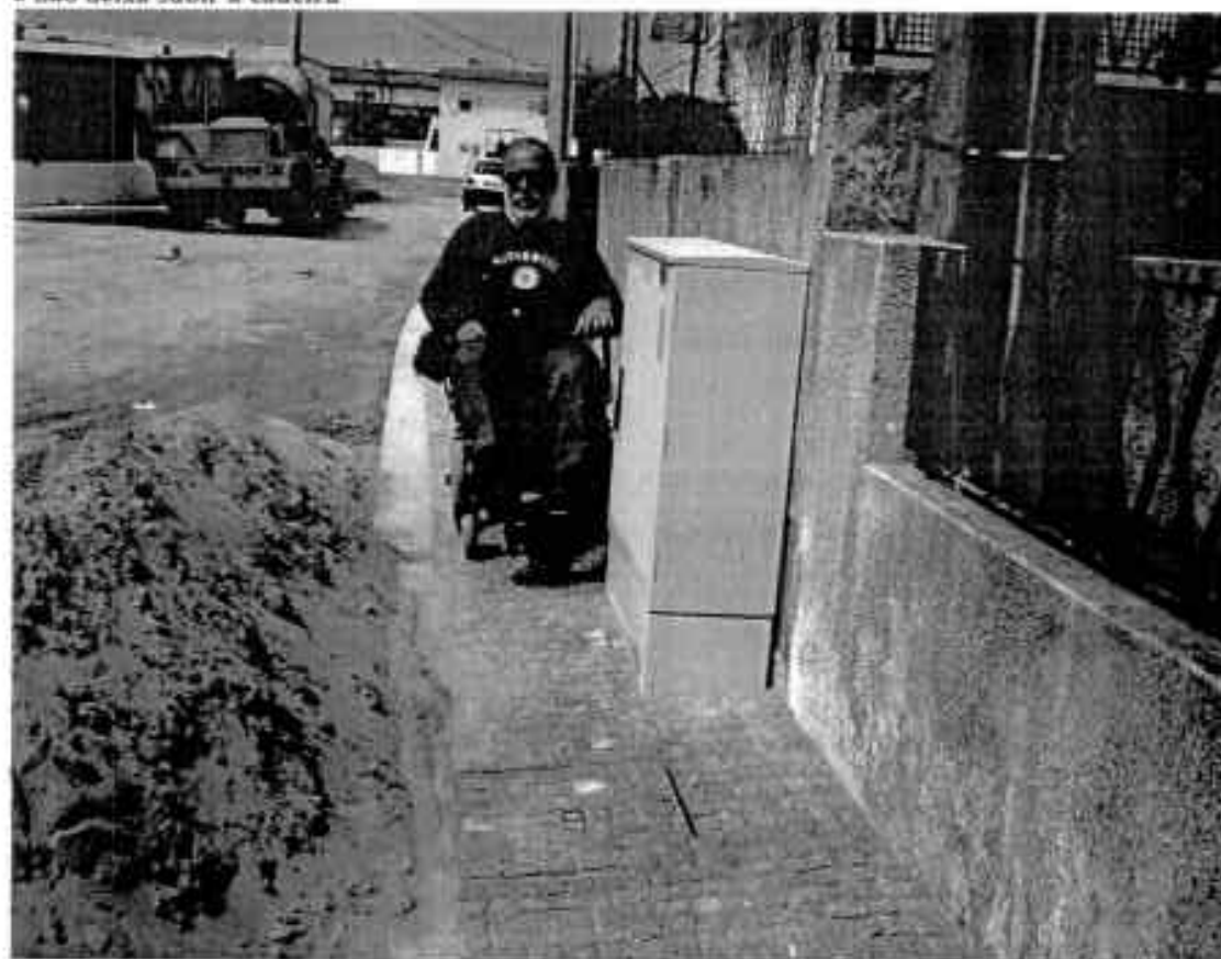
Ilustração 3 devido à inclinação da rampa de PASSADEIRA as rodas de emergência tocam no chão e não deixa subir a cadeira
