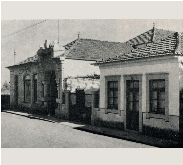
Figura 25 - Fachada do edifício e Posto Médico que se encontra no catálogo de 1952
