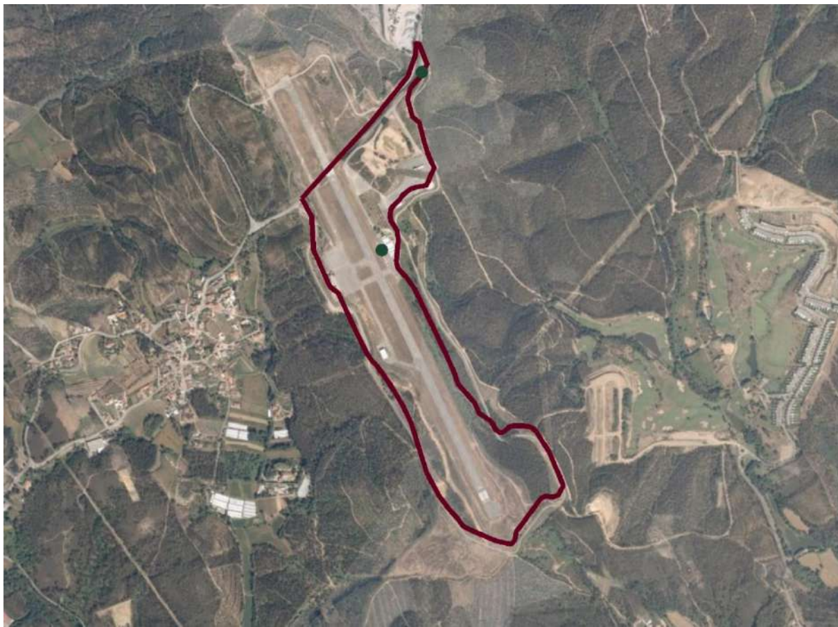
Figura 82. Ciclovia do Aeródromo Municipal de Vilar de Luz
