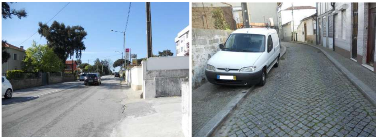
Figura 145. Ausência de canais de circulação pedonal (esquerda) e estacionamento abusivo (direita)
