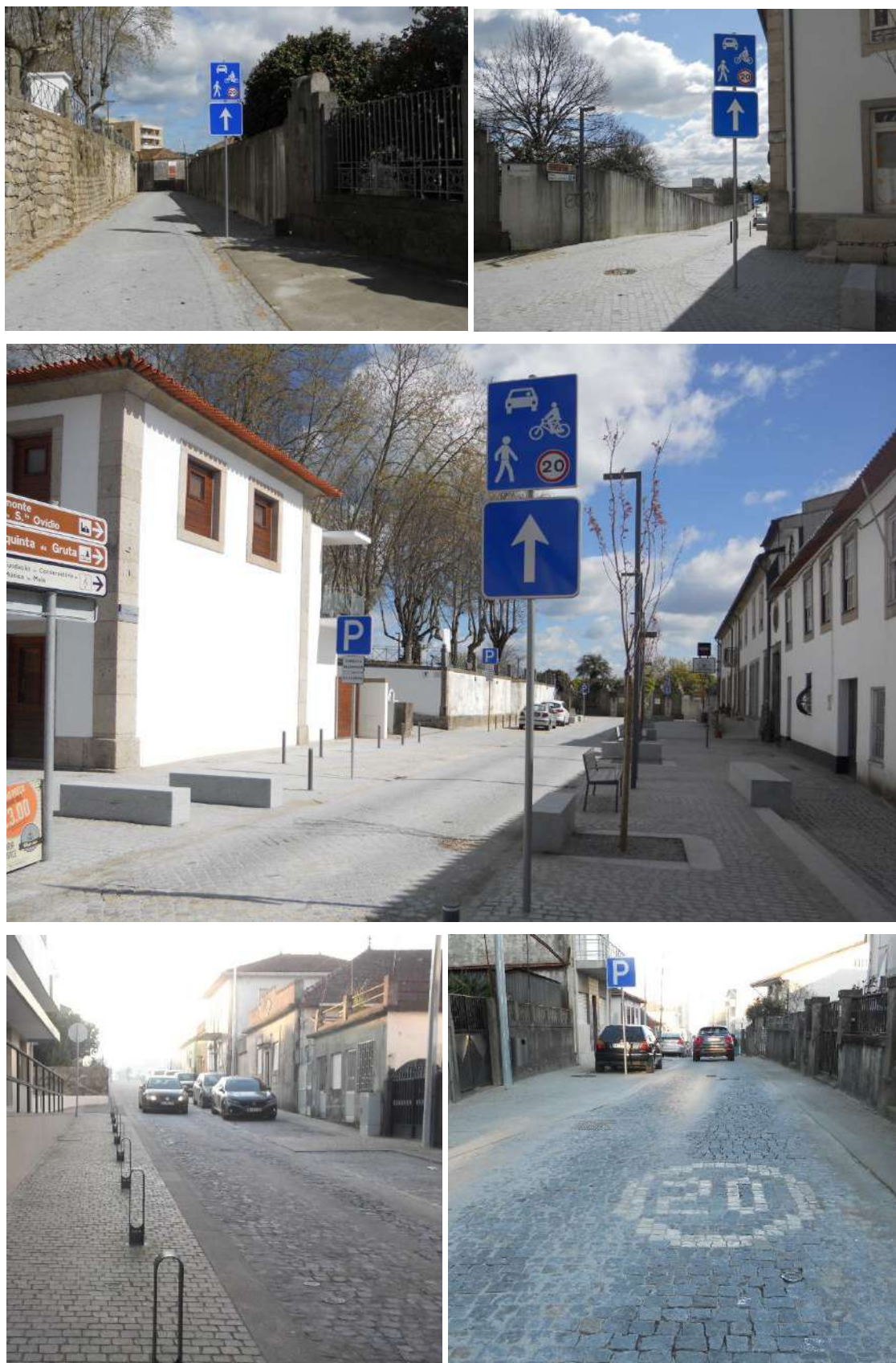
Figura 101. Exemplo de zona de coexistência no município da Maia, na Praça 5 de Outubro, na Rua de João Maia e na Rua Clotilde Ferreira da Cruz
