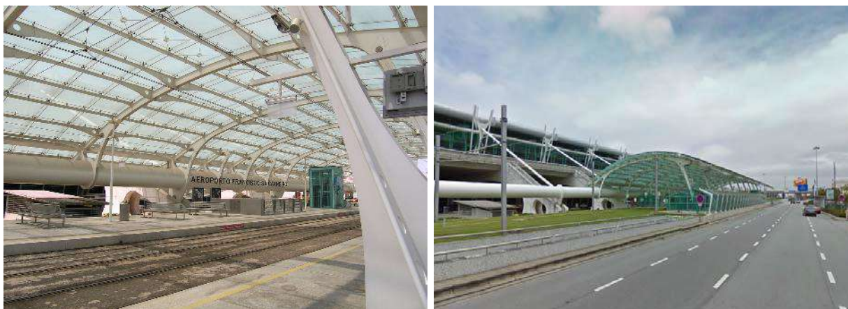
Figura 114. Estação de Metropolitano do Aeroporto Francisco Sá Carneiro
