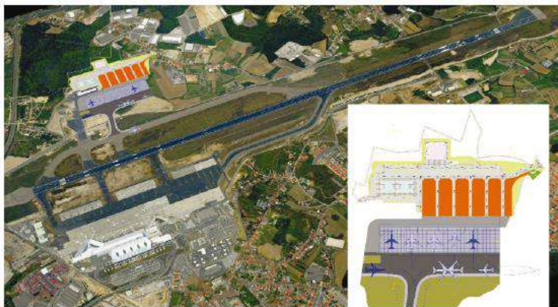
Figura 140. Centro de Carga Aérea do Aeroporto Francisco Sá Carneiro
