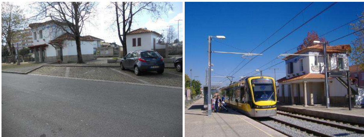
Figura 121. Estação de Metropolitano de Castelo da Maia
