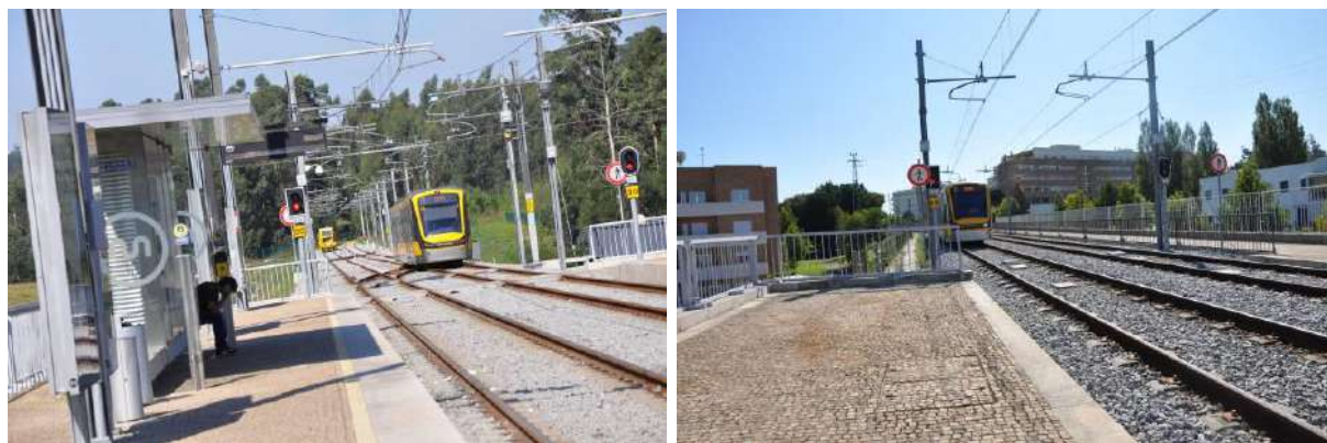
Figura 123. Estação de Metropolitano do ISMAI
