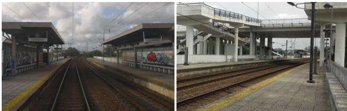
Figura 119. Apeadeiro Ferroviário de Leandro
