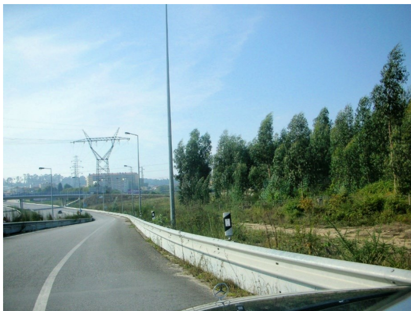
Zona ao longo do tramo de acesso onde será construído o muro
