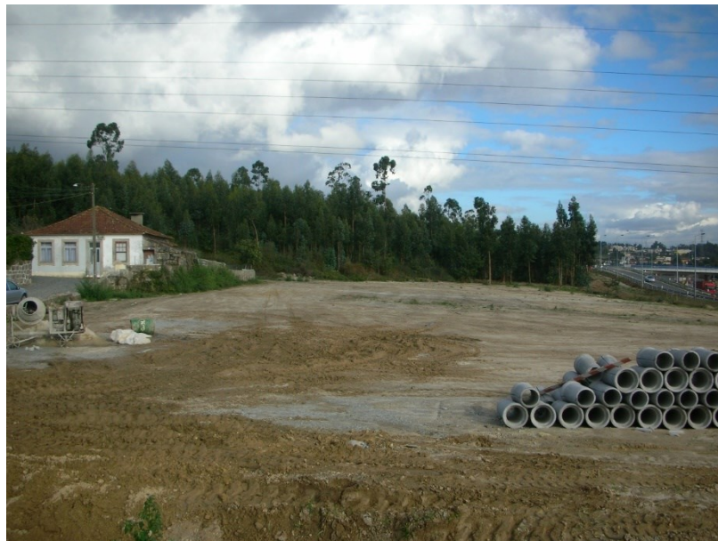
Terreno onde será implantado o edifício de serviços
