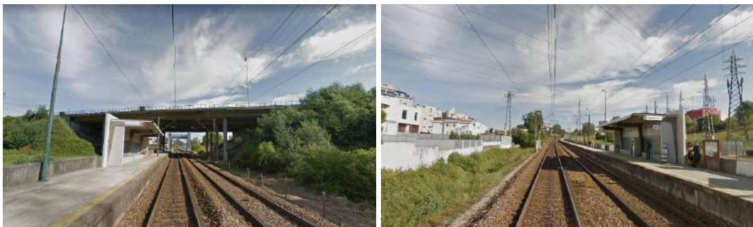
Figura 115. Apeadeiro Ferroviário de Águas Santas
