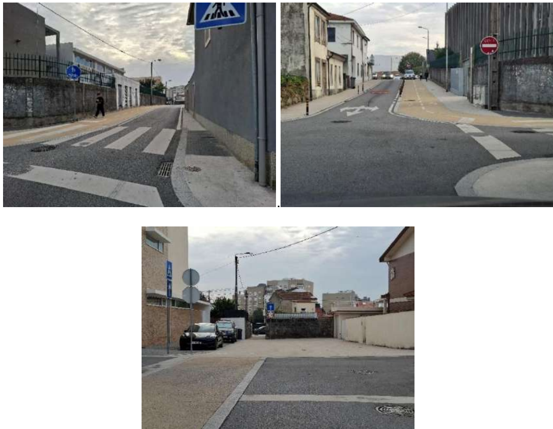
Figura 73. Registo fotográfico da ciclovía de Águas Santas
