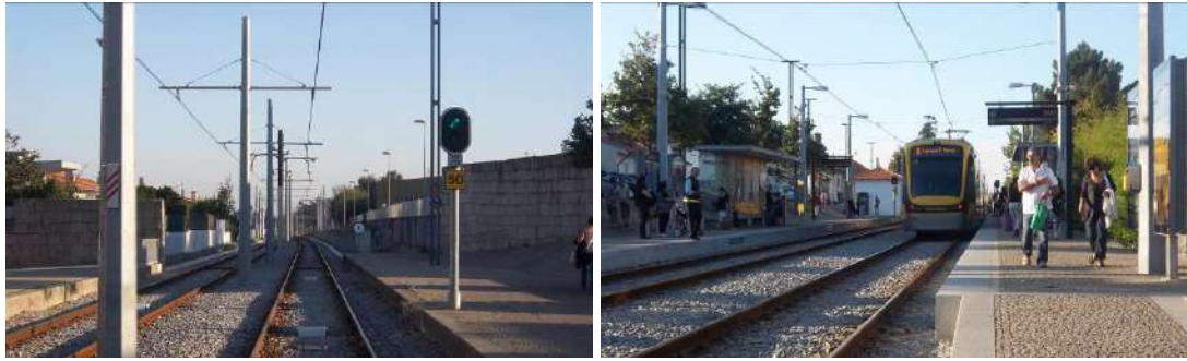
Figura 121. Estação de Metropolitano de Pedras Rubras
