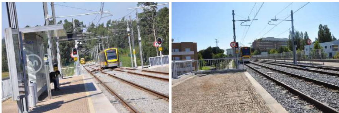
Figura 120. Estação de Metropolitano do ISMAI
