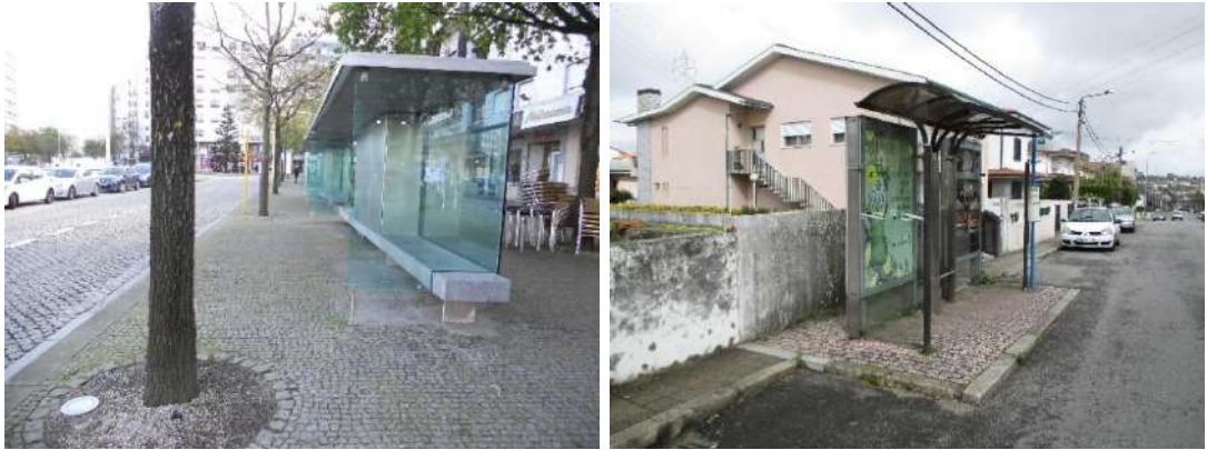
Figura 99. Discrepâncias infraestruturais observadas nos pontos de acesso alocados à cidade da Maia
