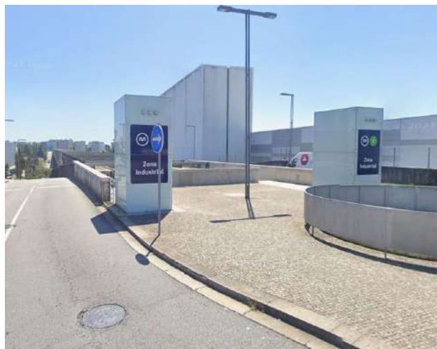
Figura 124. Estação de Metropolitano da Zona Industrial
