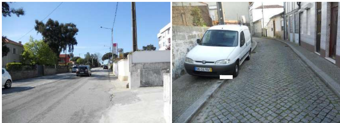
Figura 155. Ausência de canais de circulação pedonal (esquerda) e estacionamento abusivo (direita)
