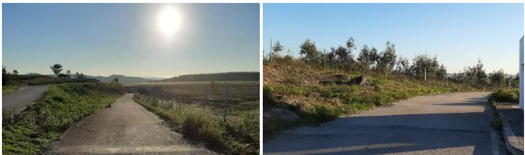
Figura 70. Registo fotográfico da ciclovía do Aeródromo
