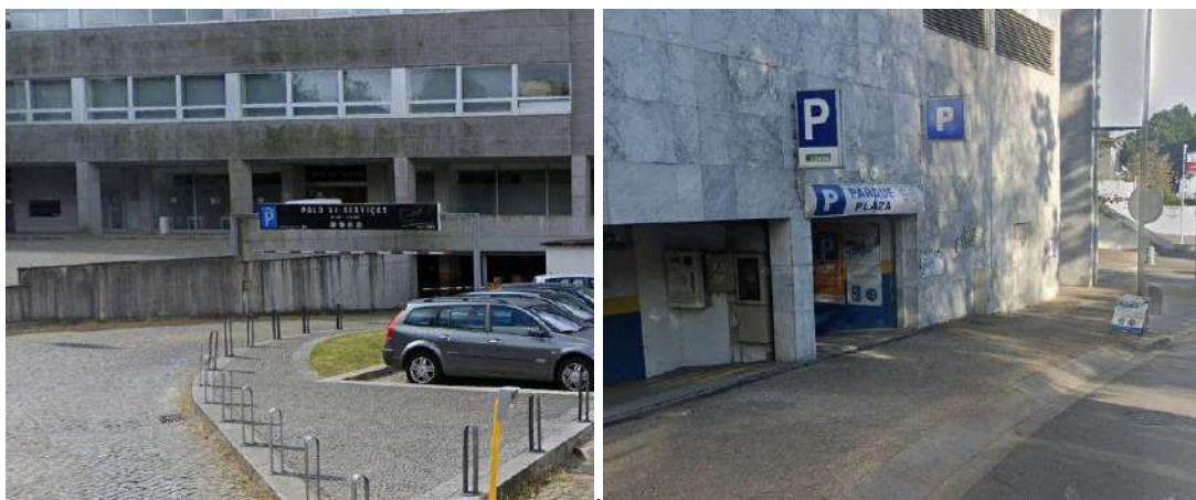
Figura 130. Parques de estacionamento subterrâneos: Parque no edifício Trofa Saúde (esq.) e Parque Plaza (dir.)
