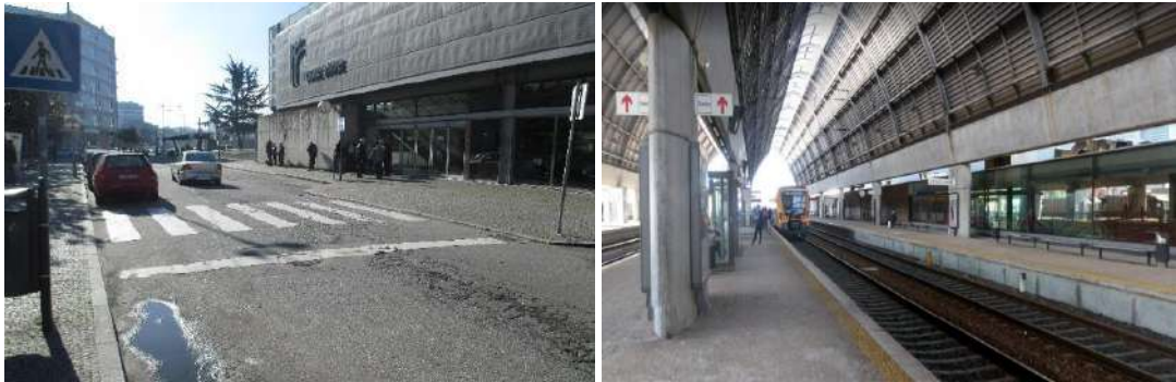
Figura 112. Estação Ferroviária de Ermesinde
