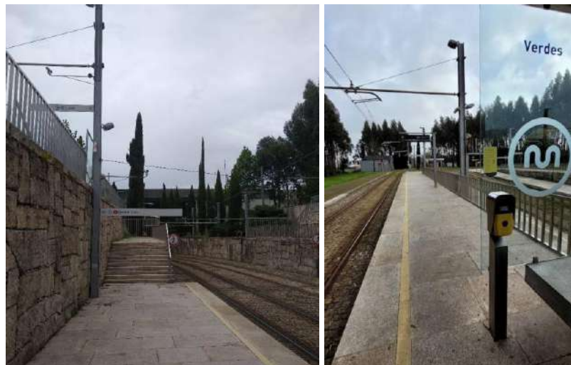
Figura 123. Estação de Metropolitano de Verdes
