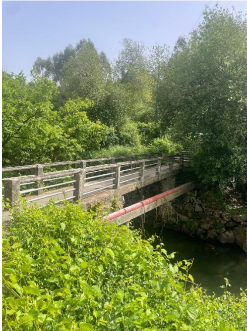
Figura 2. Aspeto da ponte PT06, margem direita do rio Leça.
