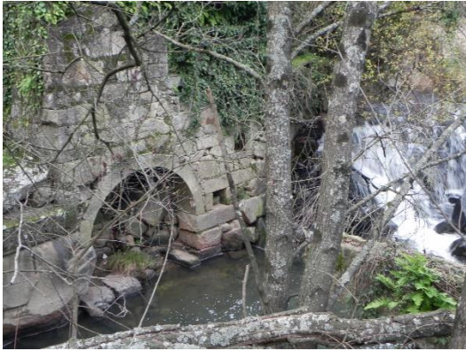
Figura 8. Arco de volta perfeita na zona de saída de água do moinho.
