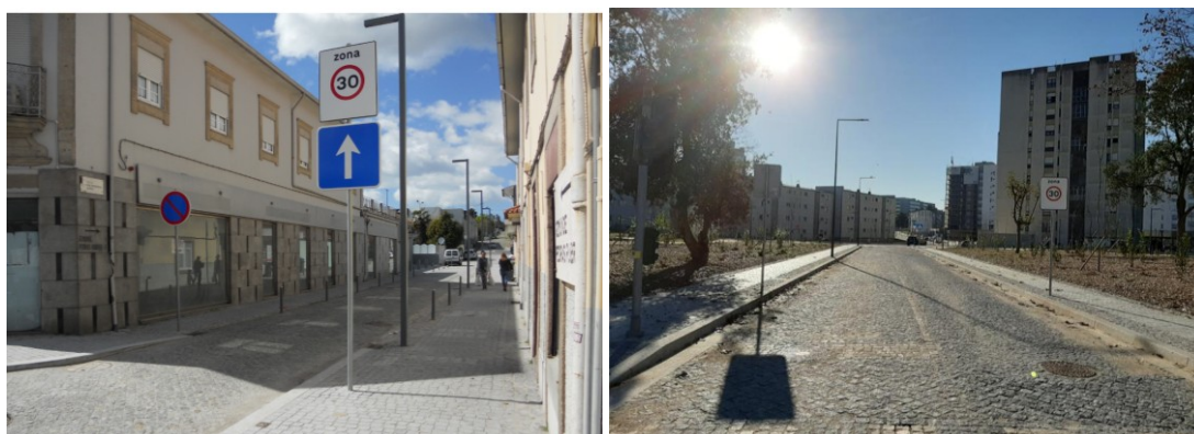
Figura 9. Sinalização de zona 30 existente na Rua Engenheiro Frederico Ulrich e Rua Altino Coelho (2020)
