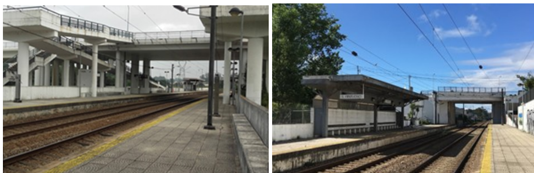
Figura 42. Atuais condições de acesso pedonal aos apeadeiros ferroviários de Leandro (esq.) e São Frutuoso (dir.)
