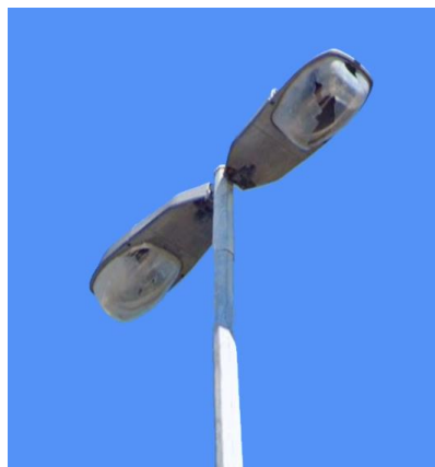
Figura 19 - Luminárias Sujeitas a uma Atmosfera Corrosiva na Zona Industrial da Maia 9
